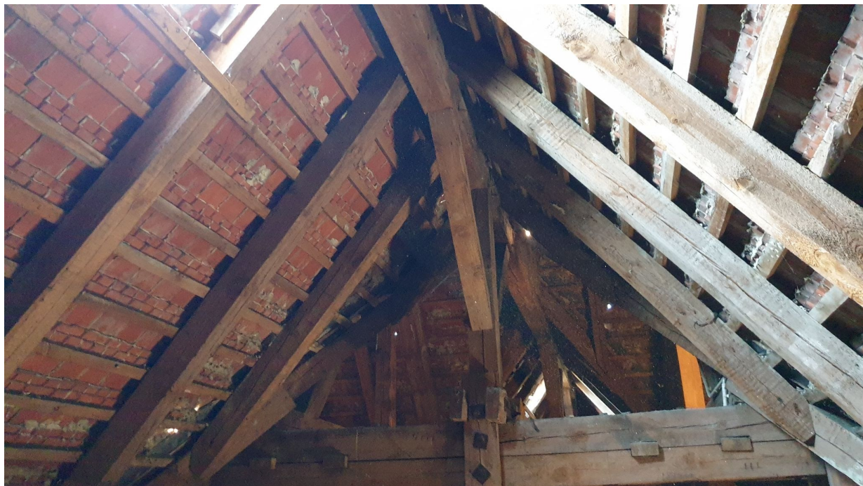
01. WIDOK OGÓLNY WIĘZBY DACHOWEJ
