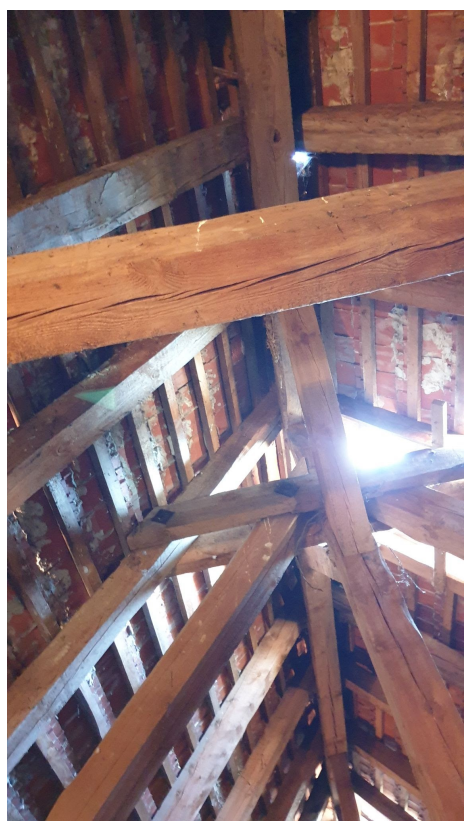
02. WIDOK OGÓLNY WIĘZBY DACHOWEJ
