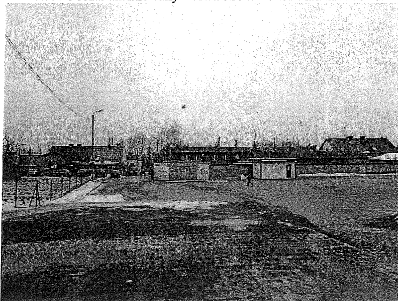
Fot. 4. Obszar analizowany – przedmiotowy teren i okoliczna zabudowa.
