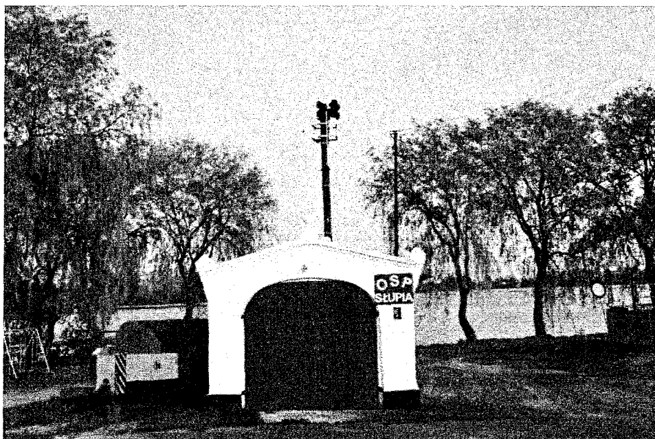
Fot. 5 Widok na OSP Słupia i jezioro Strykowskie od strony ul. Słonecznej.
